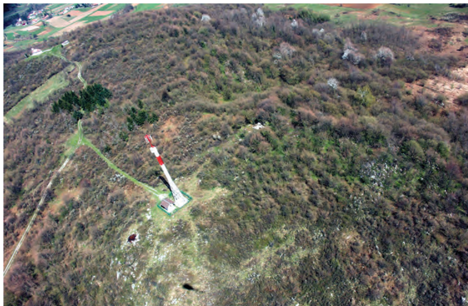
Pogled iz zraka na repetitor i sondu 4 desno od njega, travanj 2006. (Foto B. Olujić)
