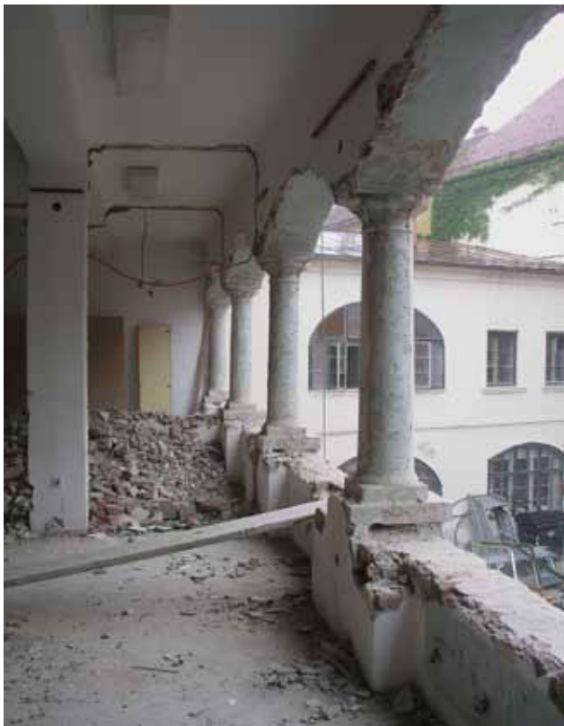
24 Otvaranje zazidanih arkada južnoga krila (stanje 2006., foto: Željko Trstenjak)
