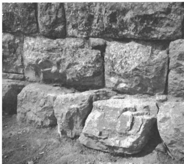
Sl. 1. Dio bedema na zapadnoj strani u fazi otkrivanja, s bunjama koje su se odvalile od zida
