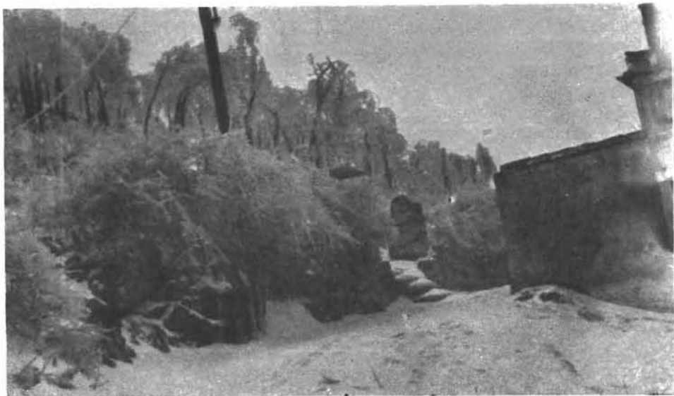
8. Ugao zgrade Uboškog doma (Alessanijeve situacije). Između ugla i šume put „vodi na Loredanova vrata“. Iza ugla, u džibunju položaj H na mapi iz g. 1889. Snimljeno u siječnju g. 1942.
