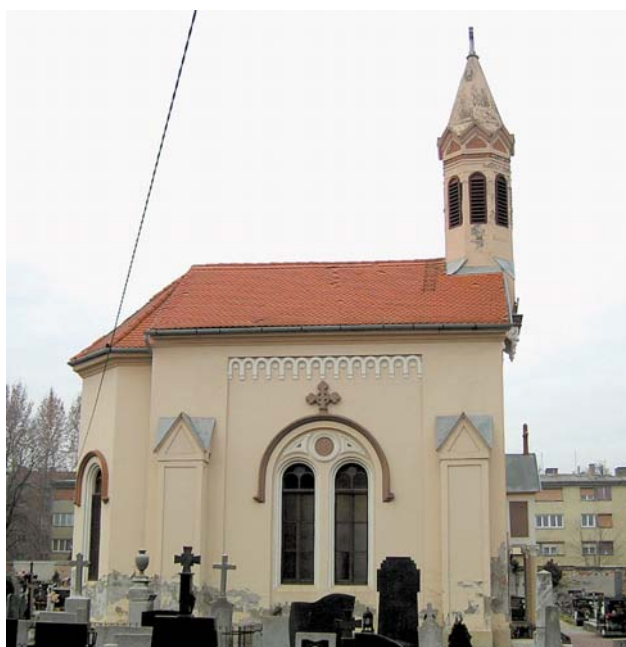
Bočno pročelje kapele svetog Leopolda na novogradskom groblju u Osijeku
