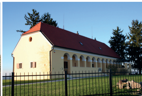
Slika 19: Dvorac Tkalec, pogled s jugoistoka
