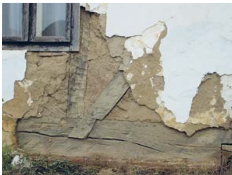
Slika 6. Način vezanja okomitih i kosih gređa na osnovnu noseću gređu ( pocek ) - primjer kuće iz Novigrada Podravskog, Ulica Blaža Magjera 128 (R. Ibrišević)
