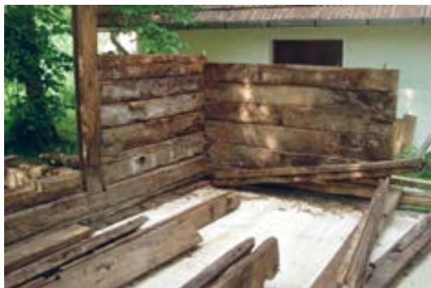
Slika 12. Početak obnove drvene hiže - na ovom primjeru će se tesane daske ( planjke ) vezati na nemški vugel - objekt je postavljen na imanju Hećimović u Jagnjedovcu 2010. godine (P. Somek, 2010.)
