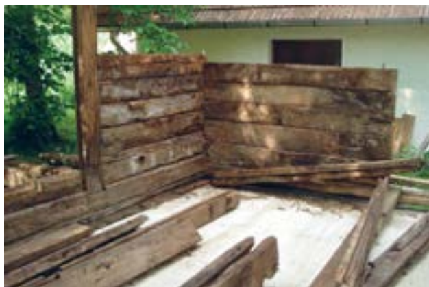
Slika 12. Početak obnove drvene hiže - na ovom primjeru će se tesane daske ( planjke ) vezati na nemški vugel - objekt je postavljen na imanju Hećimović u Jagnjedovcu 2010. godine (P. Somek, 2010.)
