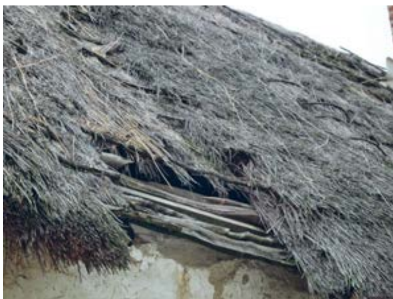
Slika 7. Ražene ritke na krovu je vezalo vrbovo pruće i šibe - primjer kuće iz Novigrada Podravskog, Ulica Blaža Magjera 128 (R. Ibrišević)
