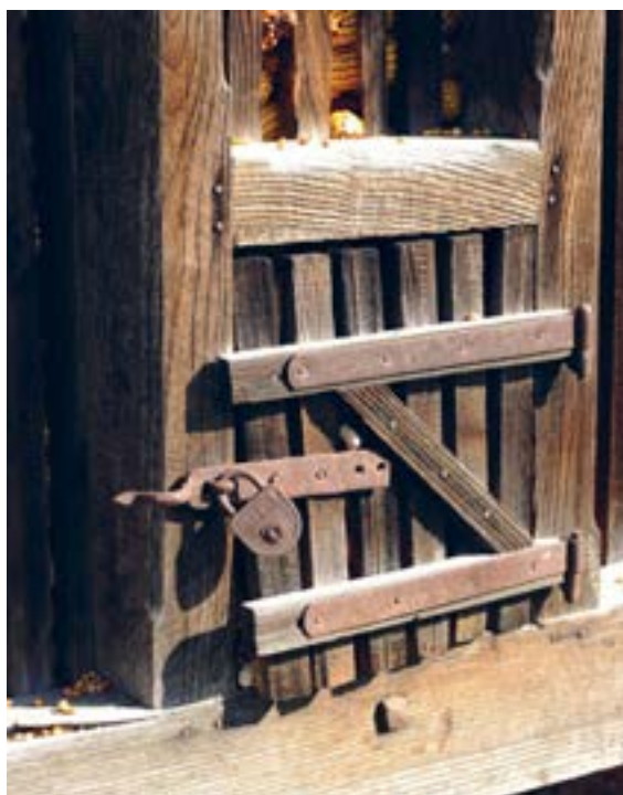
Slika 16. Konstrukcija vrata na kukuružnjaku ( letvanom košu ) - primjer iz Torčeca (R. Ibrišević, 2011.)
