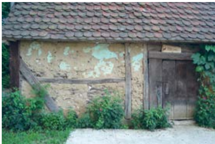
Slika 17. Kanatna konstrukcija s pleterom ocupanim ilovačom na vinogradarskoj klijeti na Staroj gori južno od Virja (P. Somek, 2010.)
