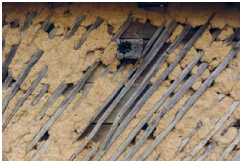
Slika 5. Na unutarnjim drvenim daskama ( planjkama ) naboj se vezao na vrbovo pruće - primjer s klijeti kod Miholjanca (R. Ibrišević, 2011.)
