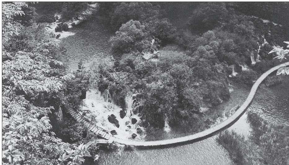
SL. 8. NP PLITVIČKA JEZERA: ZAŠTITA SEDRENIM BARIJERA – STAZE IZNAD VODE OMOGUĆUJU SLOBODAN PROTOK VODE NA SEDRENIM BARIJERAMA.
