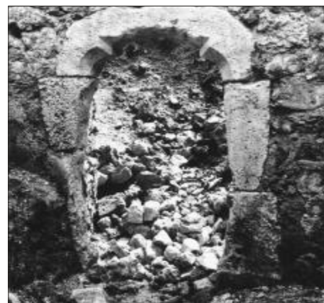
Sl. 13. Ruzica, burg, dovratnik na ulazu u podrum u južnom krilu palače
