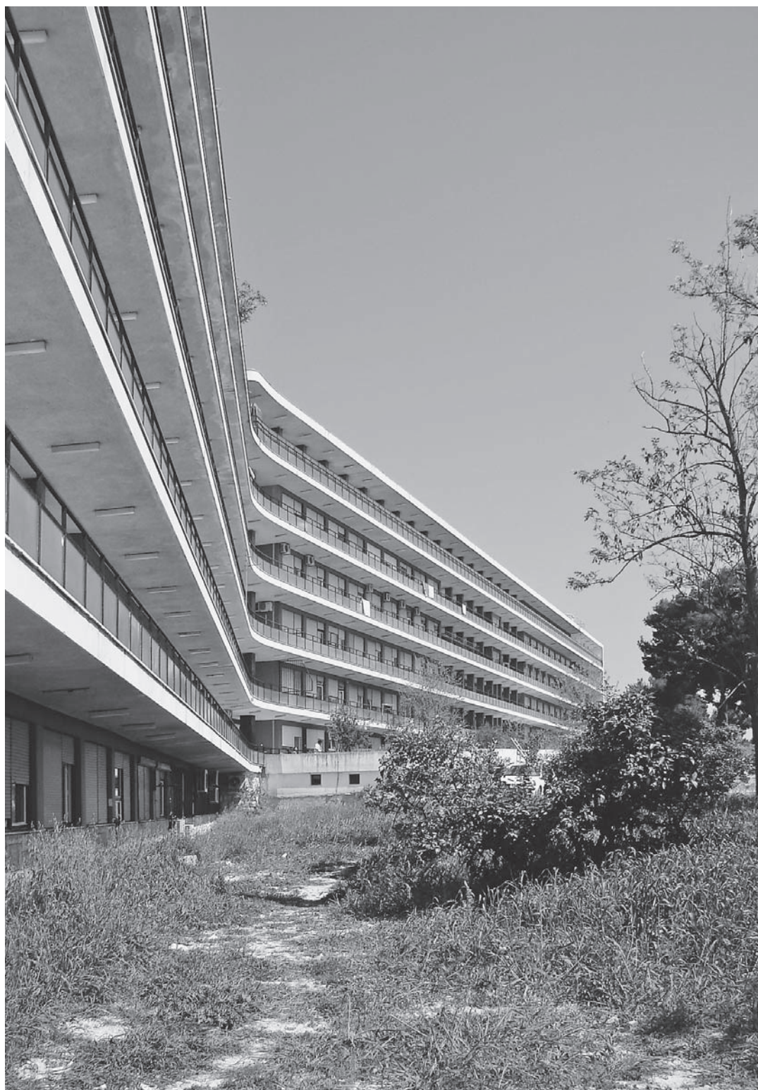
Sl. 1. GLAVNA BOLNIČKA ZGRADA OPĆE BOLNICE U SPLITU, 1951.-1969., JUŽNO GALERIJSKO PROČELJE Fig. 1. SPLIT GENERAL HOSPITAL, MAIN BUILDING, 1951-1969, SOUTH GALLERY FACADE
