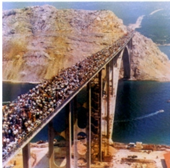
Slika 13. Početak i završetak gradnje mosta
