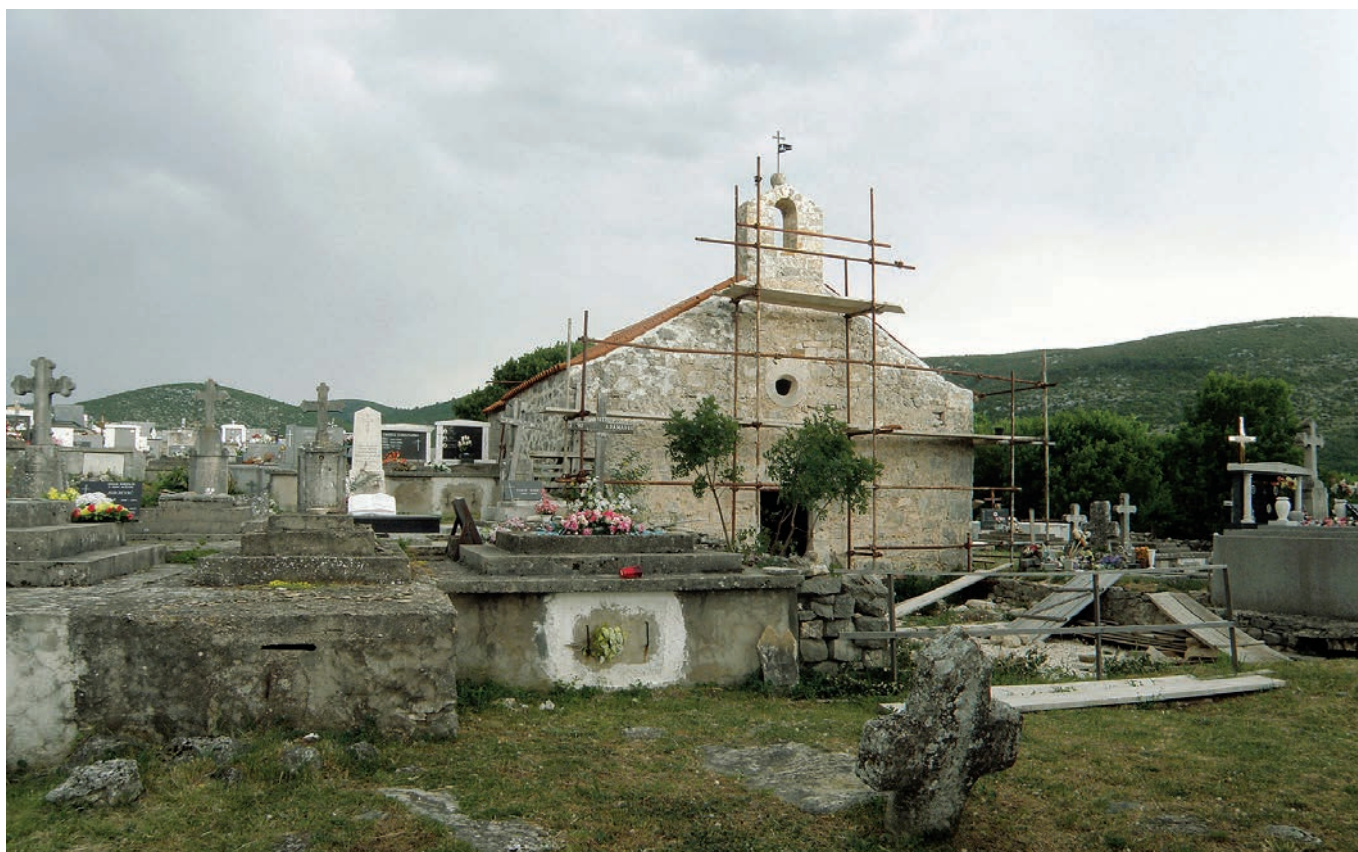
Slika 2. Obnova stare crkve sv. Jurja tijekom 2011. godine
