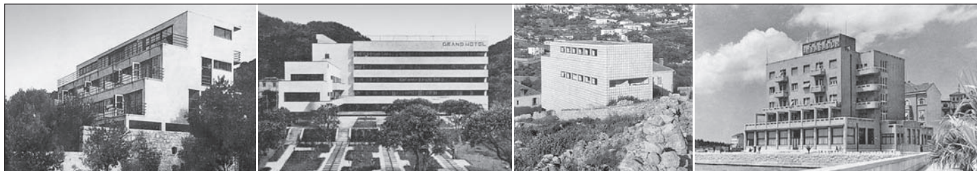
SL. 3. PRIKAZ KONTEKSTA HOTELSKE IZGRADNJE U DALMACIJI TRIDESETIH GODINA 20. ST.: HOTEL SPLENDID, UVALA LAPAD, DUBROVNIK (1935., DRAGO GALIĆ); GRAND HOTEL, LOPUD (1934.-1936., NIKOLA DOBROVIĆ); HOSTEL FERIJALNOG SAVEZA, MONTOVJERNA, DUBROVNIK (1940., NIKOLA DOBROVIĆ); HOTEL AMBASADOR, SPLIT (1934.-1937., JOSIP KODL)
