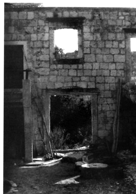
10. Ulaz u prizemlje na sjevernom pročelju, foto: D. Domančić
