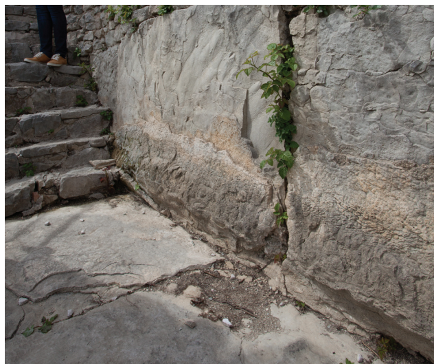
Sl. 21. Kalcifikat na stijenkama kanala (foto: Z. Sunko) Fig. 21. Calc-sinter at the channel side walls (photo: Z. Sunko)
