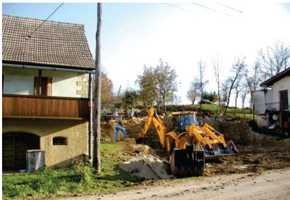
Slika 13. Prilišće – mjesto na kojem je srušena stara 'hiža s gankom'
