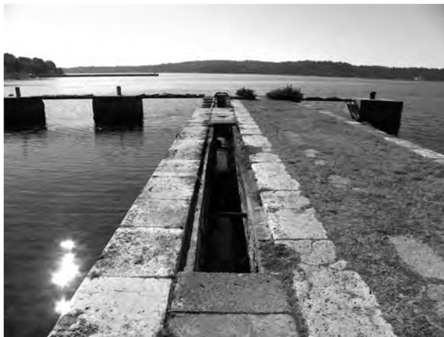
*Fig. 3. Dettaglio del molo in cui si nota perfettamente la parte originaria e a sinistra l'ampliamento nel cui canale, oggi in parte scoperto a causa dei saccheggî, passavano le condutture del combustibile.*
