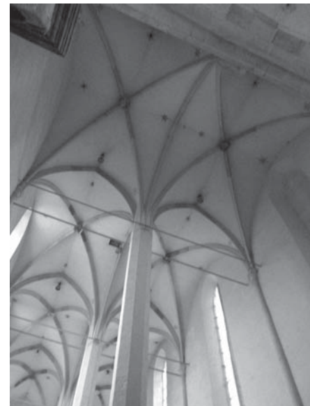
4. Crkva sv. Marije u Imbachu, svod dvobrodnog naosa na kontaktu sa svetištem (snimila M. Šimunić Buršić) / Church of St. Mary in Imbach, vault of the two-nave church body adjoining the chancel (photo M. Šimunić Buršić)
