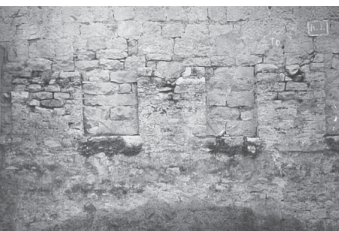
SL 75. Krunište na ogradnom zidu samostanskog dvorišta (13A) s unutarnje strane
