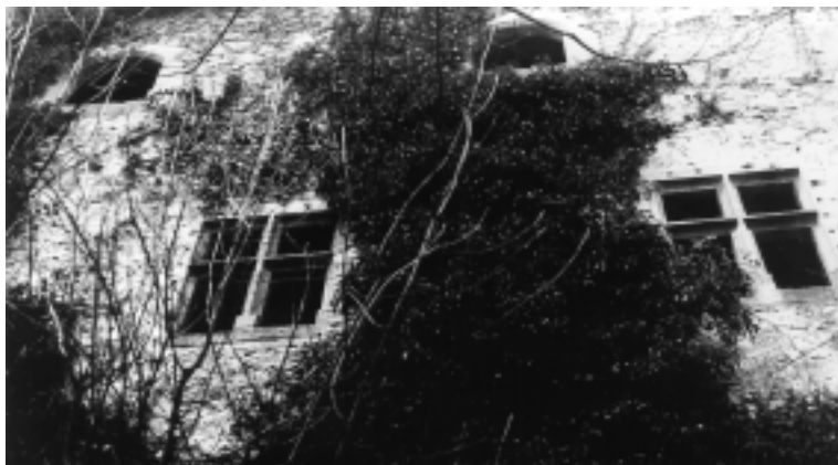
SL. 25. Ozalj, burg, prozori s kamenim šprljicama na palasu zvanom "Žitnica": na prozorskom okviru vidljive su rupe od ugrađivanja željeznih rešetki
