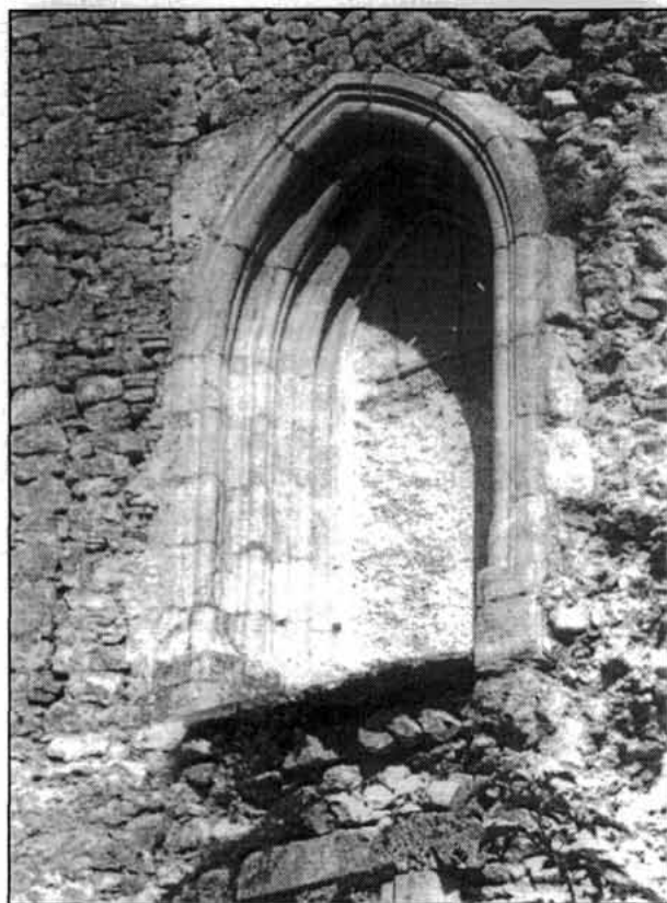
Sl. 25. Brinje, kapela sv. Trojstva, portal na zapadnom pročelju kapele, koji je vodio na kneževsku emporu – stanje prije urušavanja (snimio J. Ladović, 1954., Fototeka Uprave za zaštitu kulturne baštine Ministarstva kulture u Zagrebu)
