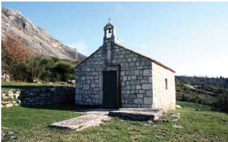
Slika 2. Crkva Sv. Đurđa Figure 2. St. George's Church
