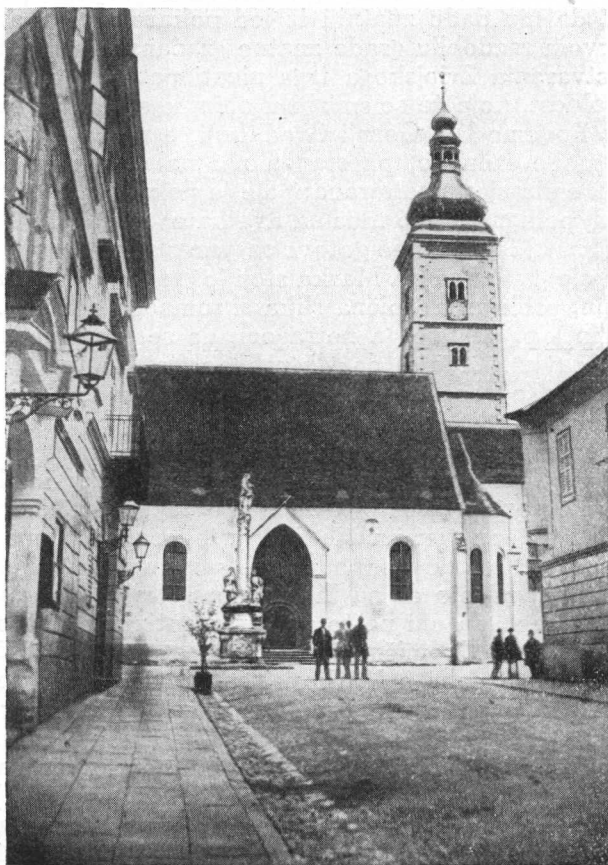
1864. Markova crkva u Zagrebu sa Marijinim spomenikom pred crkvom. Spomenik je uništen 1869. prije »restauracije«.
