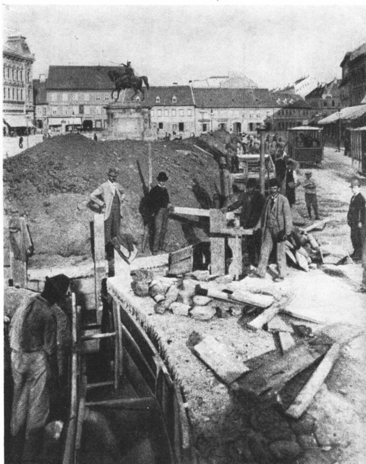
Iz vremena velikih kanalizacionih radnja u Zagrebu. Gradnja kanala na Jelačićevom trgu godine 1898.
