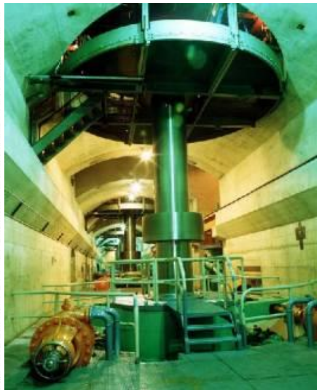
Slika 3: Osovine koje spajaju generatore i lopatice turbina
