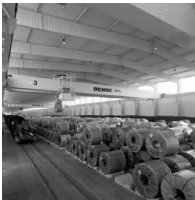
Slika 14. Objekt u sklopu terminala za rukovanje teretom u zaštićenim uvjetima
