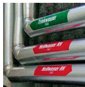
SLIKA 1 – Termoizolacijska obloga toplinskih vodova laminatom tvrtke LENZING PLASTICS
