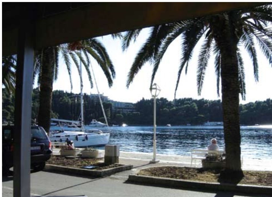
Pogled na Hotel Croatia (proj. B.Š. - 1972.-73.)
