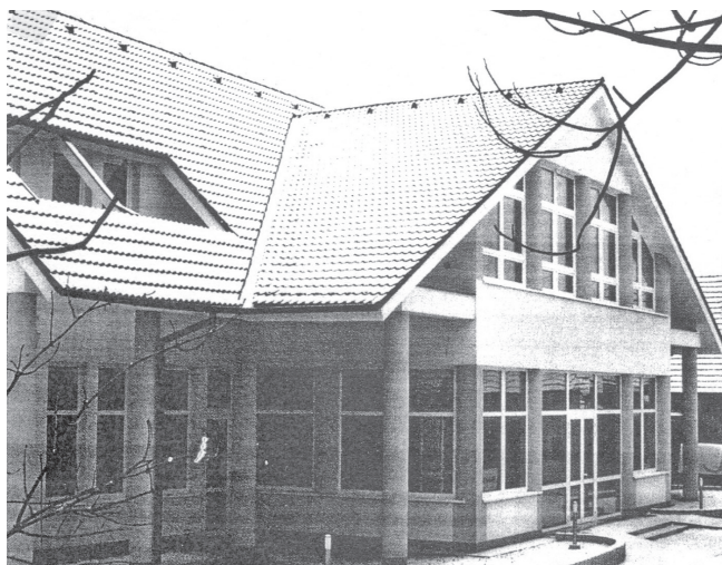
Zgrada Muzeja hrvatske kulture u Devinskom Novom Selu (Bratislava)
