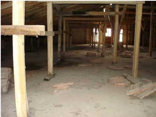
Slika 7. Drvena krovna konstrukcija na armiranobetonskoj ploči
