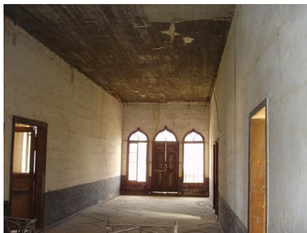
Slika 2. Armiranobetonska ploča izvedena i na stropu prvoga kata
