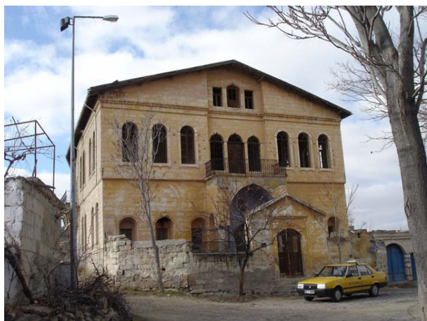
Slika 1. Ispitivana dvokatna zidana građevina
