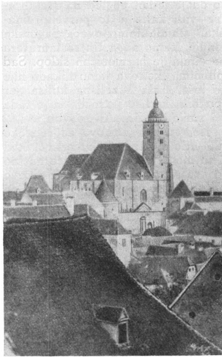
Stara zagrebačka katedrala u g. 1861. U jakim se formama prilagodila svojoj okolini, renesansni toranj izvrsno pristaje uz gotičku građevinu. Graditelj Albertal nije ni htio graditi lijevi toranj; znao je kako je tu nestalno tlo, ali je znao i to, da jedan dobar toranj vrijedi više nego dva loša!
