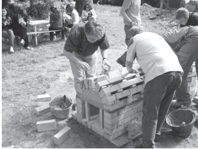
Građevinski radovi na području luka prefurnija s umetanjem tzv. kajli
