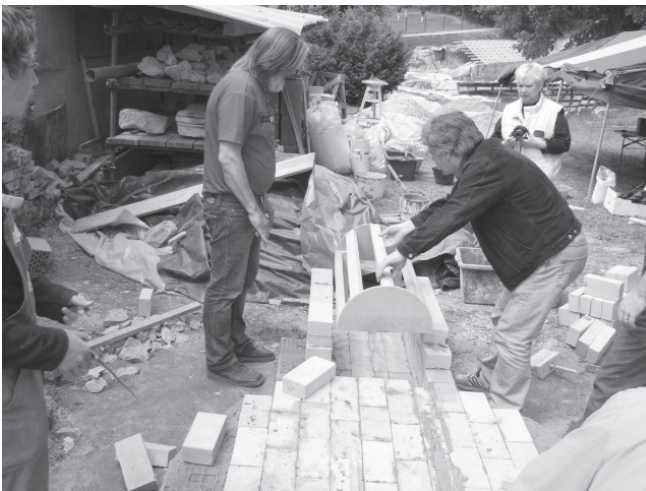
Postavljanje drvene šablone za izgradnju luka prefurnija
