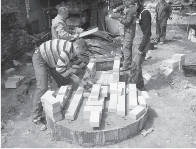
Postavljanje lagane opeke na temelj peći
