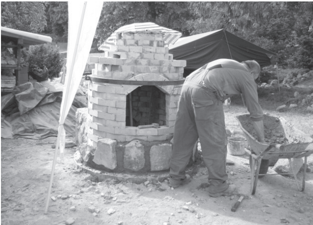
Obzidavanje peći i pogled s istočne strane na područje vrata za utovar keramičkih proizvoda
