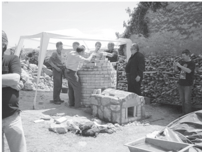
Radovi na području kupole s formiranjem otvora za pristup zraka
