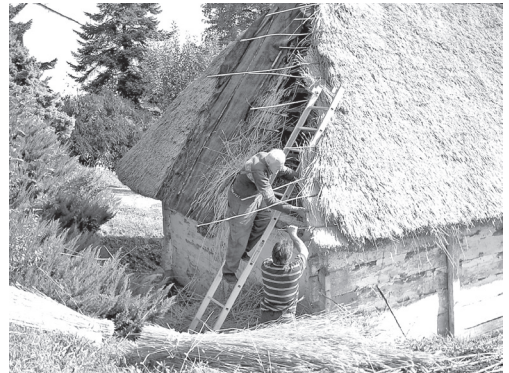
Majstor i pomoćnik prilikom umetanja ljeskovoga pruća u sloj ražene slame tijekom radova 2006.
