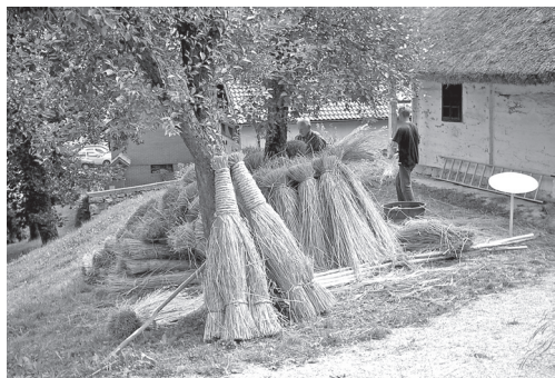
U prednjem planu prikazani su izrađeni "purani"; stanje prije pričvršćivanja na sedlo krova
