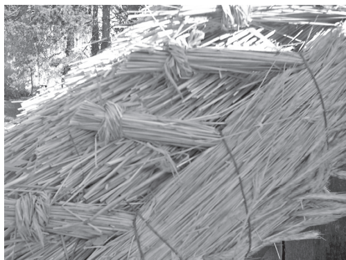
Detalj: "kukutički" nakon pričvršćivanja na krov s obnovljenim pokrovom od ražene slame
