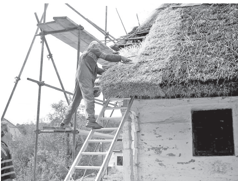
Majstor Stjepan Španić prilikom radova na istočnoj dionici krovišta kuće
