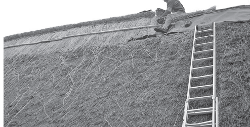
Majstor tijekom radova na polaganju ritki, tzv. "glava" na sedlu krova
