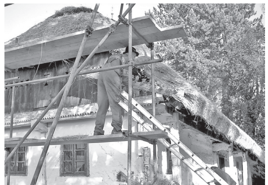
Pričvršćivanje novih "kukutičekov" na završni rubni sloj južnog dijela krovišta kuće
