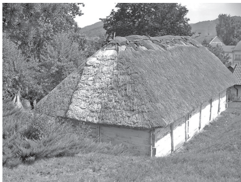
Pogled sa sjeverozapadne strane, stanje prije skidanja ljepenke sa sedla krova
