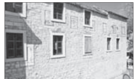
SL. 14. KASTEL CIPIKO, ISTOČNO PROČELJE S TRAGOVIMA OBRAMBENIH OTVORA IZ 1493. FIG. 14 CIPIKO CASTLE, EAST FAÇADE WITH TRACES OF FORTIFIED WINDOW FROM 1493
