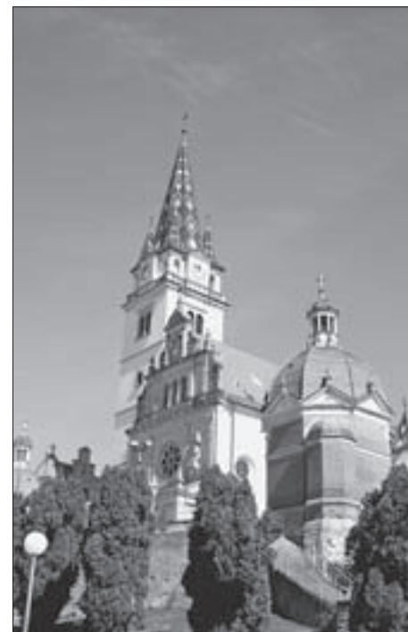
SL. 7. HODOČASNIČKI SKLOP U MARIJI BISTRICI, DANAŠNJE STANJE. RESTAURACIJA JE IZVEDENA PREMA PROJEKTIMA IZ 1879., S TOM RAZLIKOM DA NI NA JEDNOM SAČUVANOM LISTU PROJEKTA NIJE NAZNAČENO DA ĆE NA TORANJ CRKVE BITI POSTAVLJEN GLAZIRANI CRIJEP.
