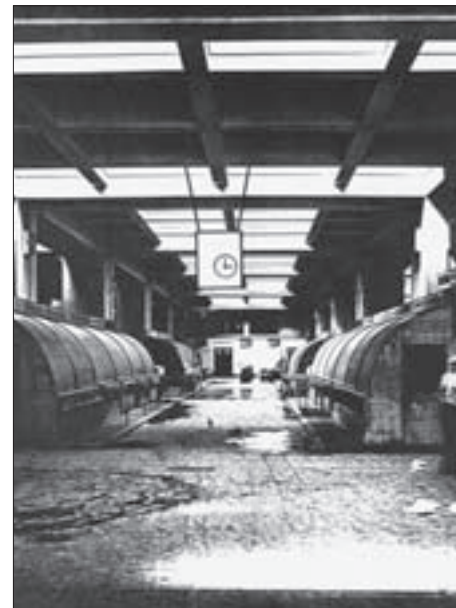
SL. 17. SUVREMENA FOTOGRAFIJA UNUTRAŠNJE TRŽNICE NAKON OTVORENJA, OKO 1930.
