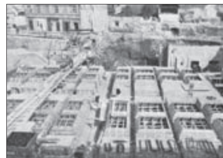
SL 12. SJEVERNI DIO GRADILIŠTA – OPLATA STUPOVA
