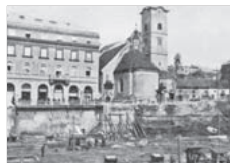
SL. 3. POGLED NA ZAPADNU STRANU GRADEVNE JAME PREMA CRKVI SV. MARIJE
