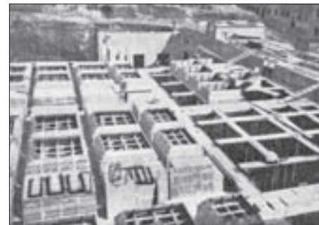
SL 7. SJEVEROISTOČNI UGAO GRADILIŠTA – POSTAVLJANJE OPLATE I BETONIRANJE STUPOVA
