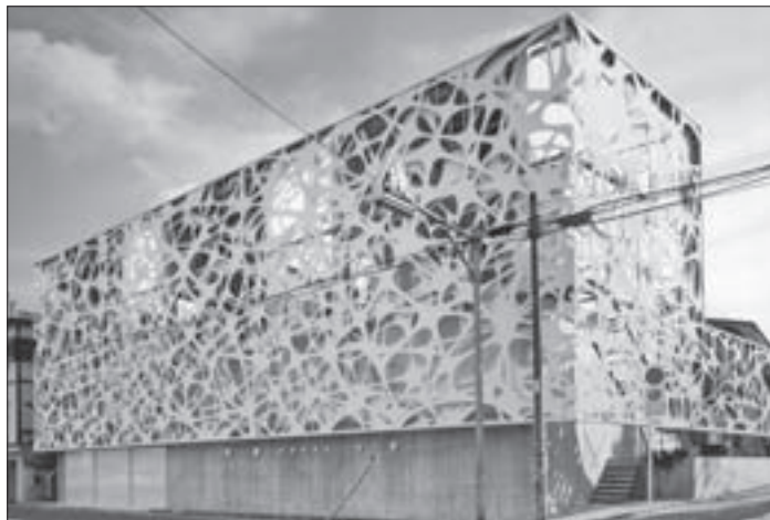
SL. 7. DVODIMENZIONALNI VORONOJEV DIJAGRAM – STANIČNA JE STRUKTURA MODIFICIRANA RAZLIČITIM PARAMETRIMA UPORABOM RAČUNSKE METODE VORONOJEVA DIJAGRAMA: VIŠESTAMBENA I POSLOVNA ZGRADA AIRSPACE, TOKIO (FAULDERS STUDIO, STUDIO M)
