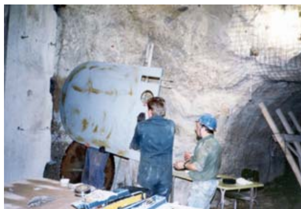
Slika 7. Ugradnja jastuka u vertikalni prorez. Vide se dimenzije ispitnog mjesta u odnosu na veličinu istražne galerije (Godar-E-Lander)
