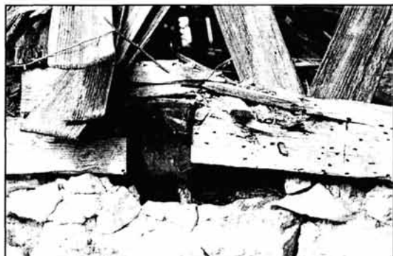
Sl. 7. Detalj krovnog veza ili ono što je od njega ostalo – vezna gređa sidrena u zid ljeskovim klinom, "coljak", rog, šimla, kolovoz 2002.
