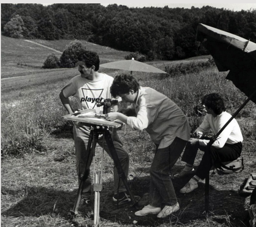
Lipnica 1986. asistent Stanislav Frangeš na stručnoj praksi za geodetskim stolom
