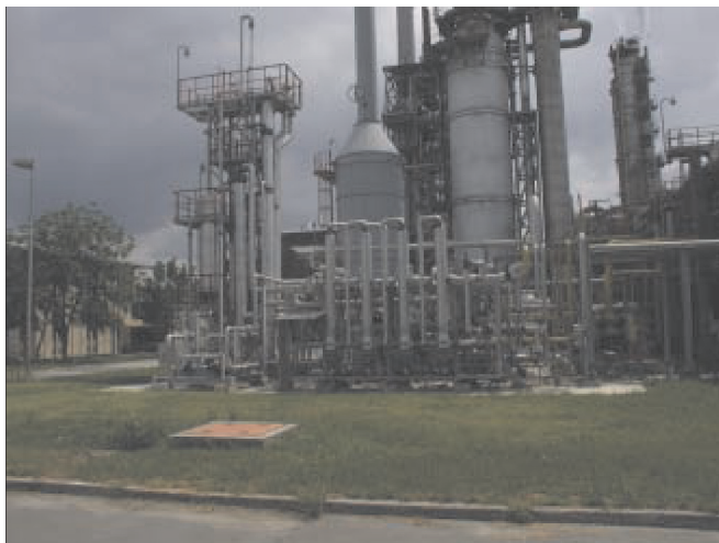
Slika 2 – U prvom planu je novo postrojenje
