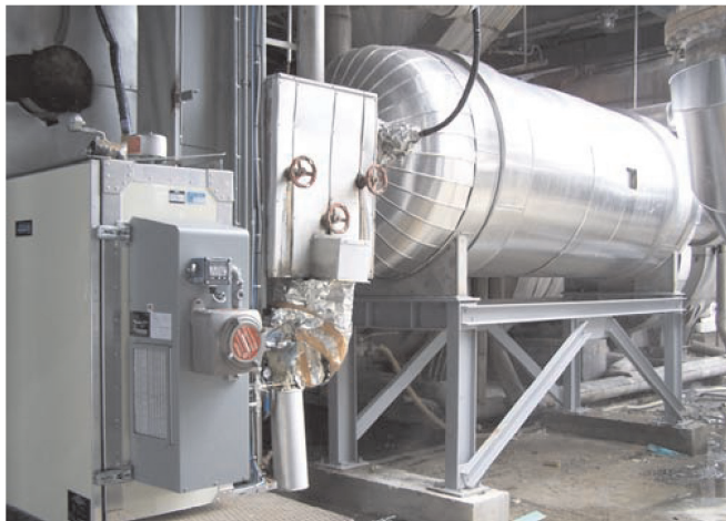
Slika 3 – Jedinica za uklanjanje dušikovih oksida iz otpadnih plinova u postrojenju Dušična kiselina 1
