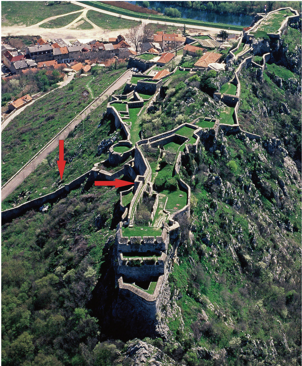
Sl. 1. Pogled na kaštel Tnin iz zraka, četvrtastu kulu i položaj crkve sv. Stjepana (foto: Z. Alajbeg; računalna obrada: J. Jelić).
