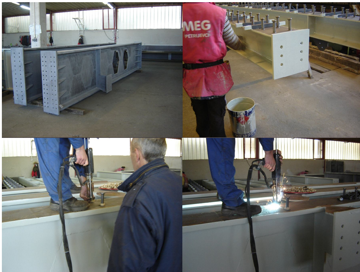
Slika 14 – Priprema čelične konstrukcije u radionici
