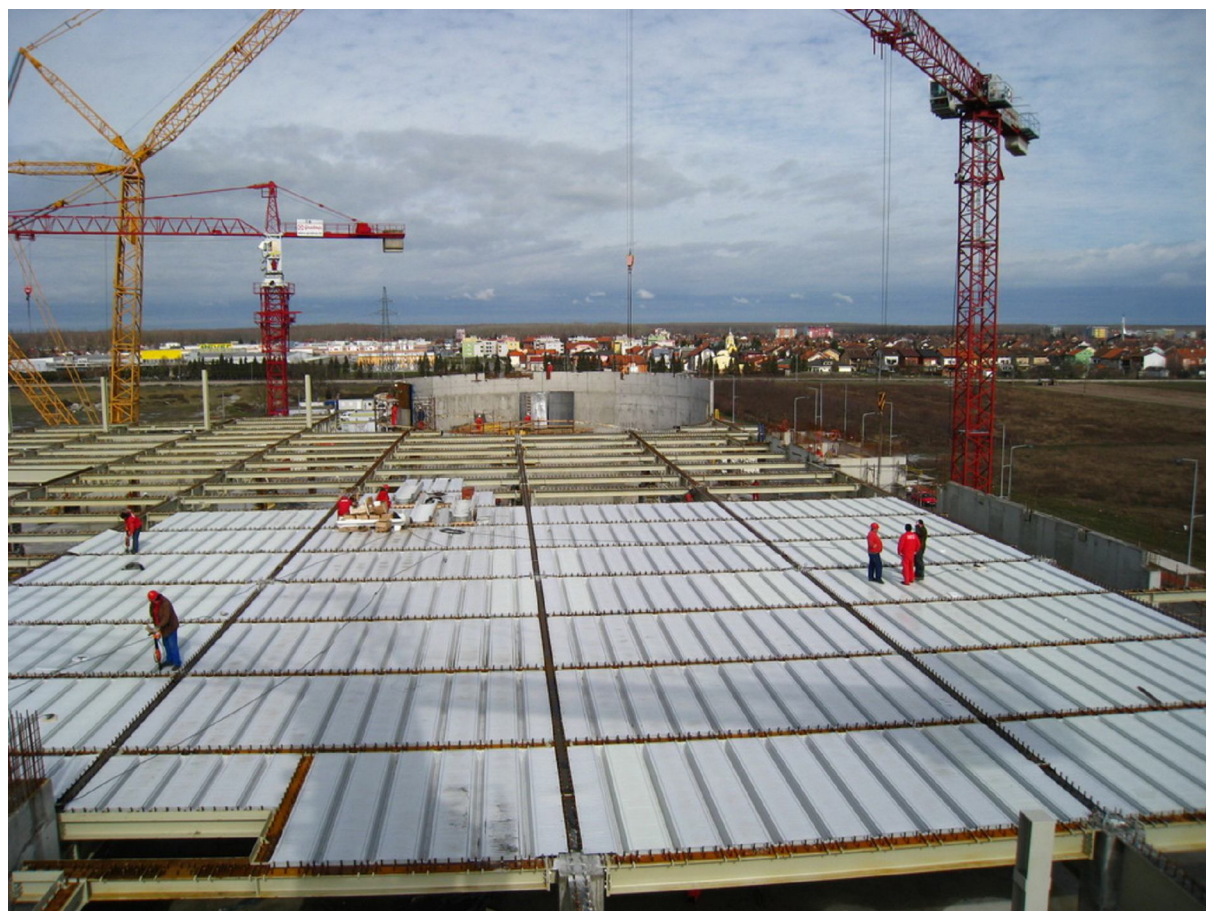
Slika 9 – Detalji izvođenja spregnute ploče
