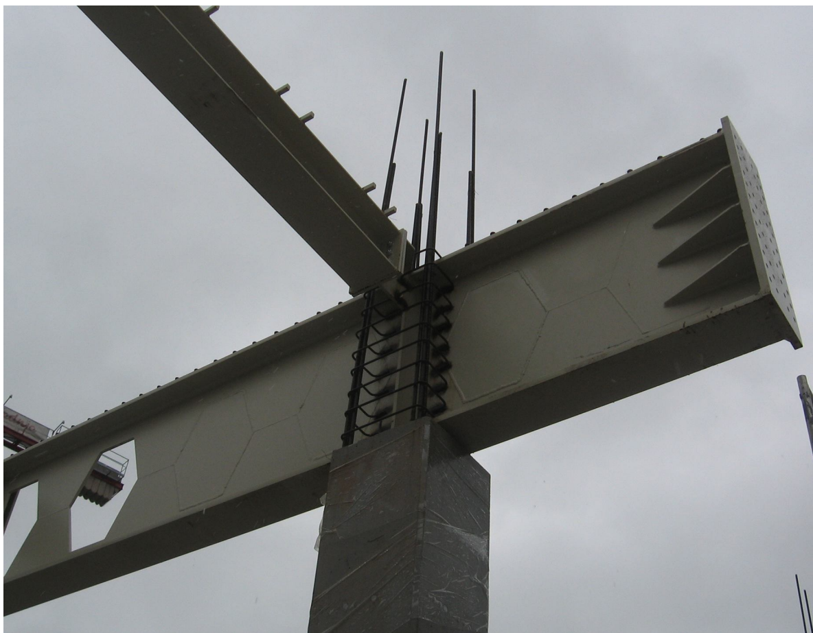
Slika 18 – Detalj zavarivanja vilica na čelični nosač prije betoniranja
