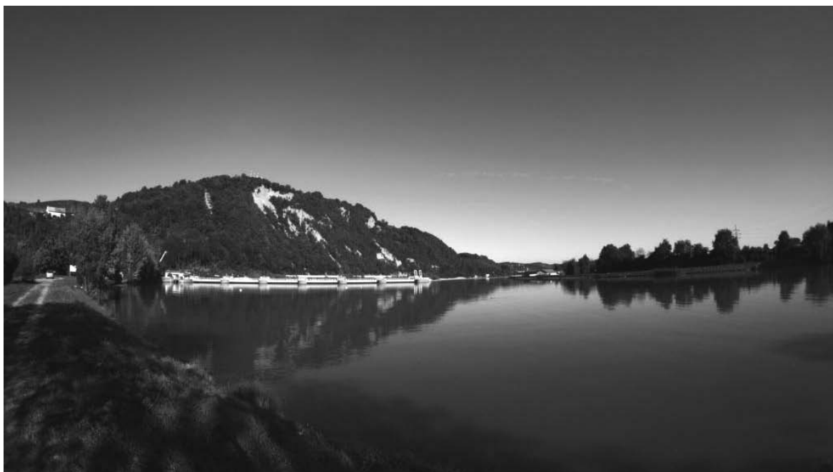
Sl. 10 Zaradi zaježitve Drave v Melju se je od leta 1969 gladina v rečnem koritu dvignila v povprečju za 3,5 m, kar je pomembno spremenilo obseg vodnega telesa Drave v Mestu. Na fotografijo vidimo jez v Melju pod Meljskim hribom, kjer se voda v Dravi razcepi v kanal HE Zlatoličje, del vode pa gre v staro strugo. (Foto: Igor Žiberna)
