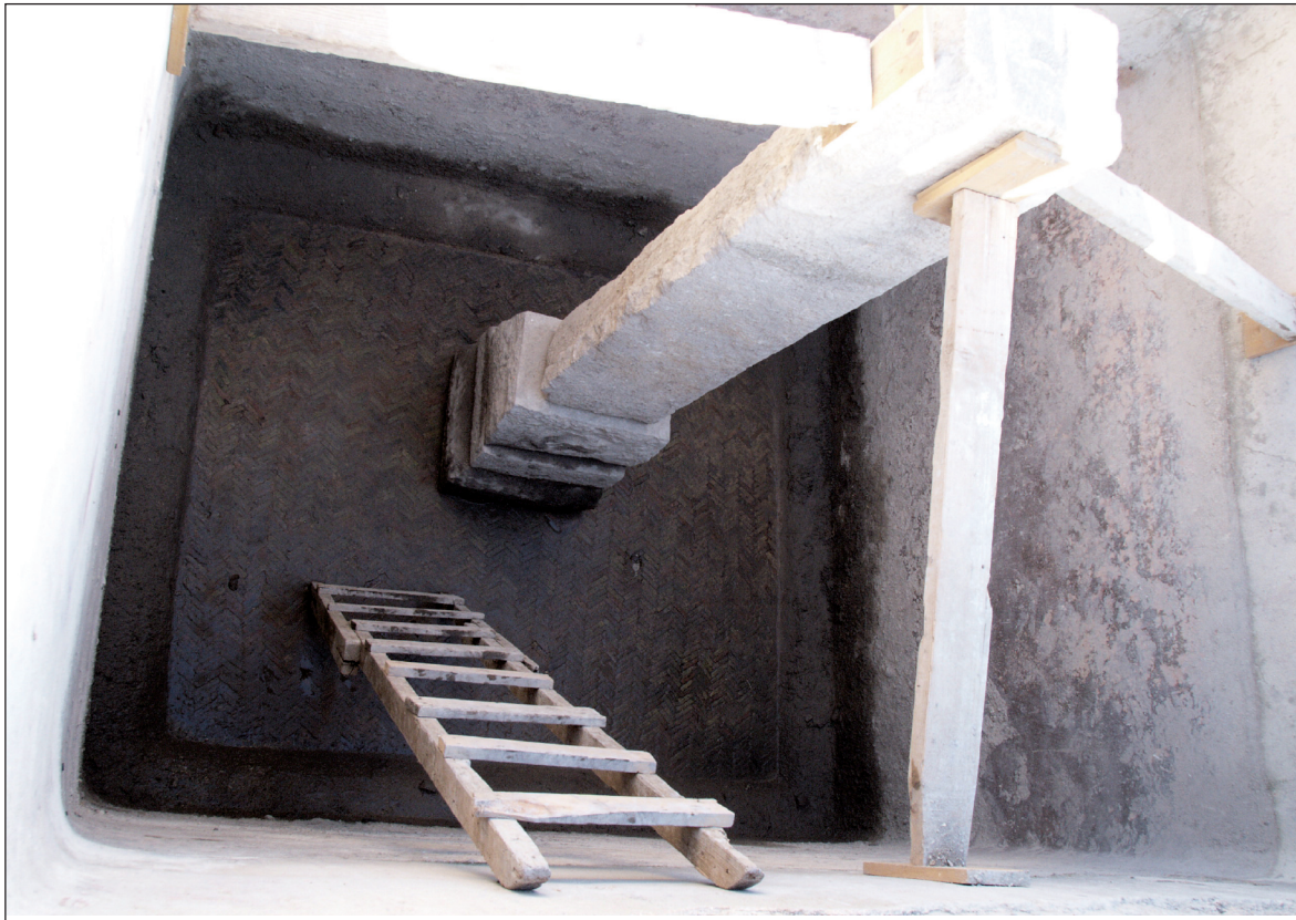
Sl. 4. Antička cisterna u urbanom tkivu grada kod novih istočnih vrata.
