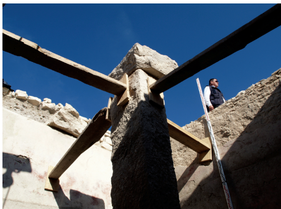
Sl. 4. Pogled iz cisterne na zaštitnu konstrukciju centralnog stupa.
