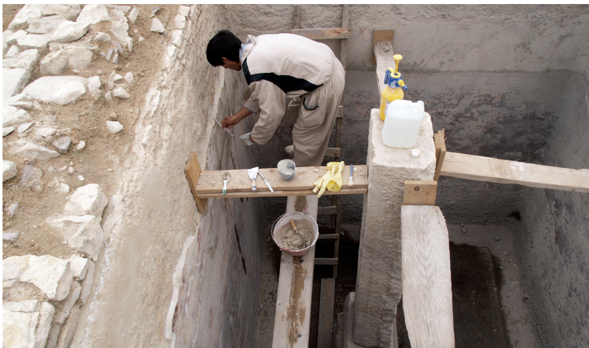
Sl. 11. Konzervatorski radovi na cisterni.
