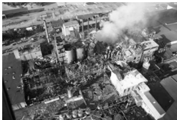
Slika 14. Posljedice eksplozije uzrokovane ležajem u postrojenju tvrtke „Imperial Sugar Company“
