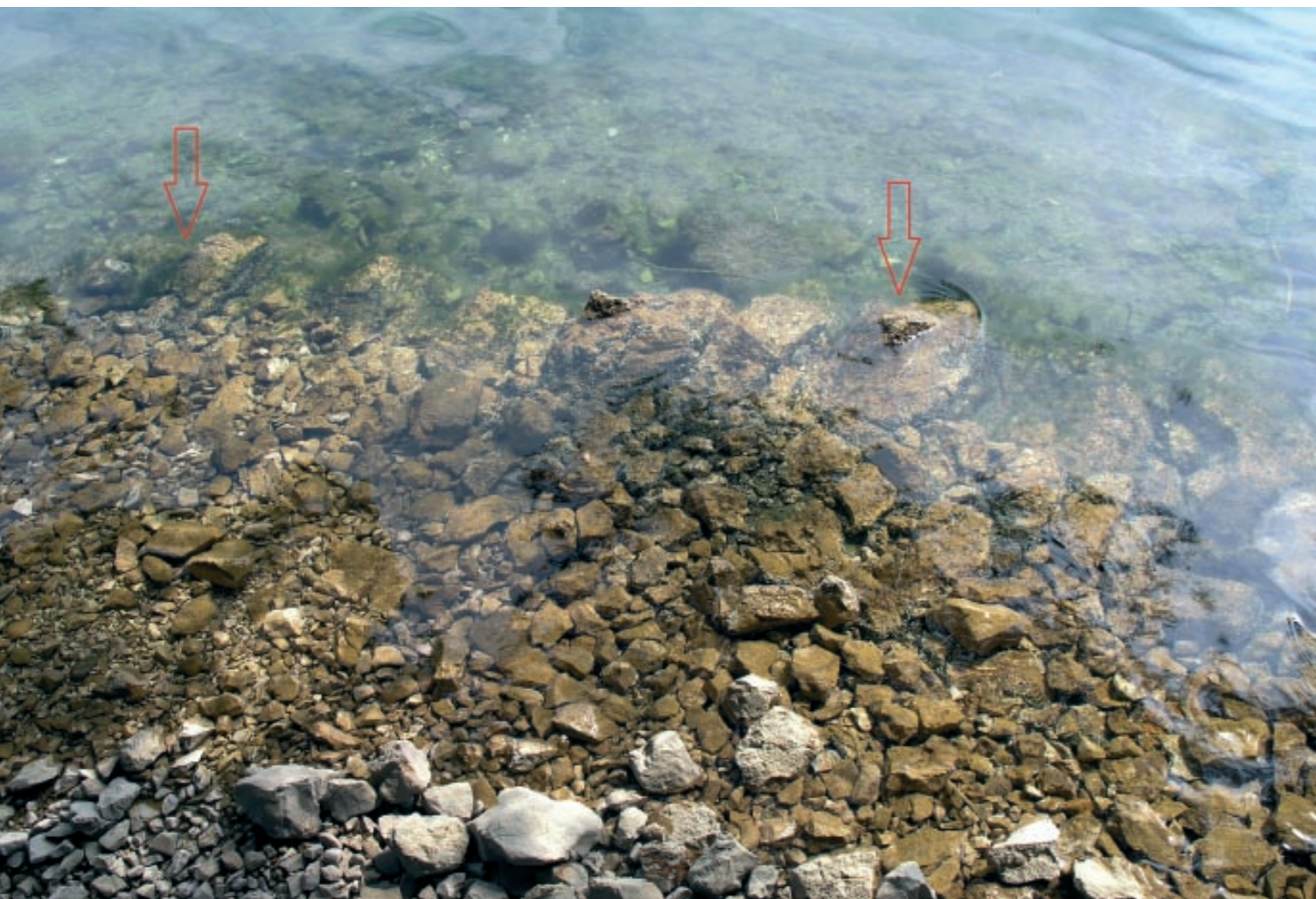
Slika 23. Dio zidane operativne obale luke antičke Skardone (foto Ivo Glavaš)
