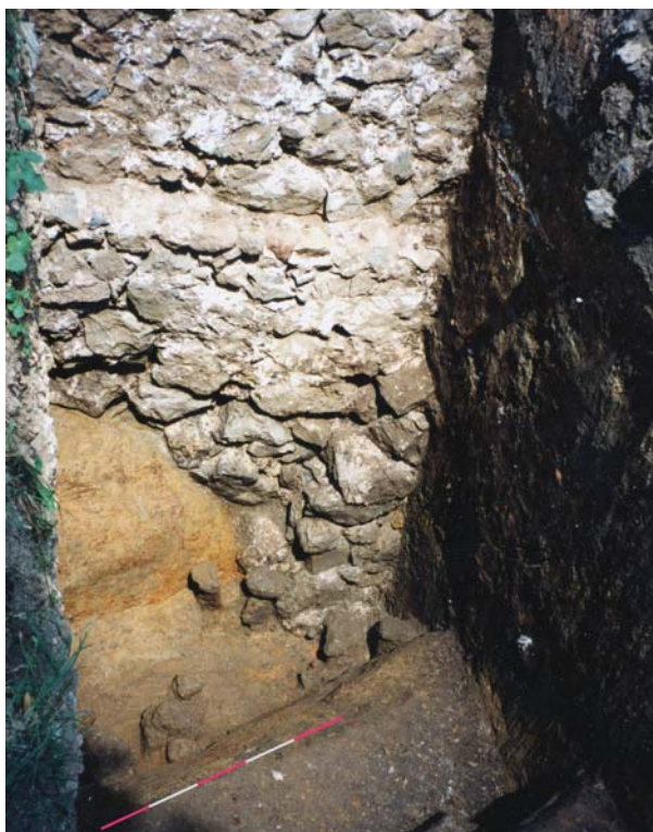
Slika 12. Kasnosrednjovjekovni obodni zid s temeljnom stopom ispod kojega se nalazi ostatak ranije gradnje; također je vidljiv ukop za zid iz kojega je naknadno povaden kamen (mjerilo: 1 m) (snimio: L. Čučković).
