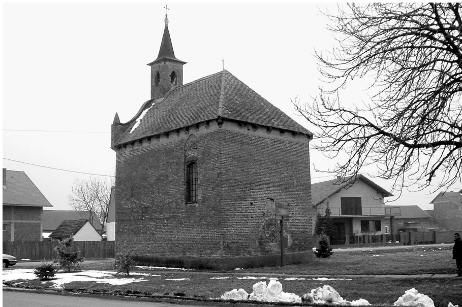
19. Gorjani. Pogled na sjeverno i zapadno pročelje osmanske kule (snimio Aleksandar Guteša, 26. II. 2003)
